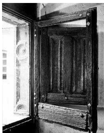
Exemple de cadre dormant (Château de) Chateaumorand à Saint-Martin d'Estreaux (42)
