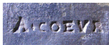
La mise au jour des poinçons des artisans ferronniers peut permettre de dater la quincaillerie et la fabrication de la menuiserie.
