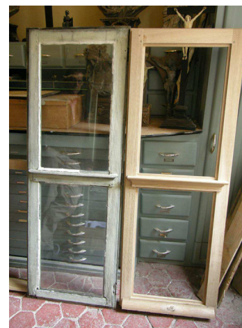
Restitution d'une fenêtre à l'identique Pommiers en Forez (42) Restauration par J.F. Grange-Chavanis, A.C.M.H.
