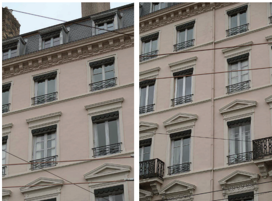
Manque d'harmonie dans le dessin des menuiseries de la façade 5, quai de la Pêcherie, Lyon Photographie : Luc Goupil
