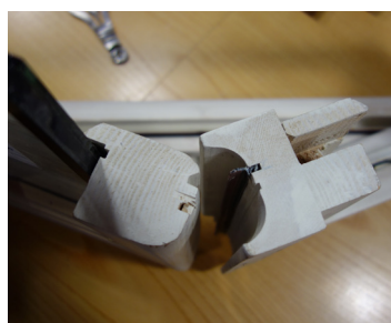
Intégration de joints pour amélioration des performances techniques
