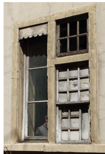
Photographie depuis la rue des Augustins à Lyon - fenêtre à coulisse
